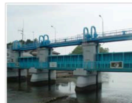
水門の施工例
