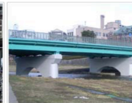
不定形橋脚での施工例
