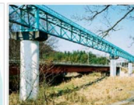
水管橋の施工例
