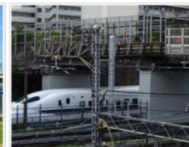
建築限界の厳しい施工例
