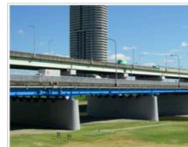
河積阻害率の制約下での施工例
